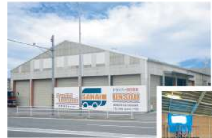
横浜配送センター
